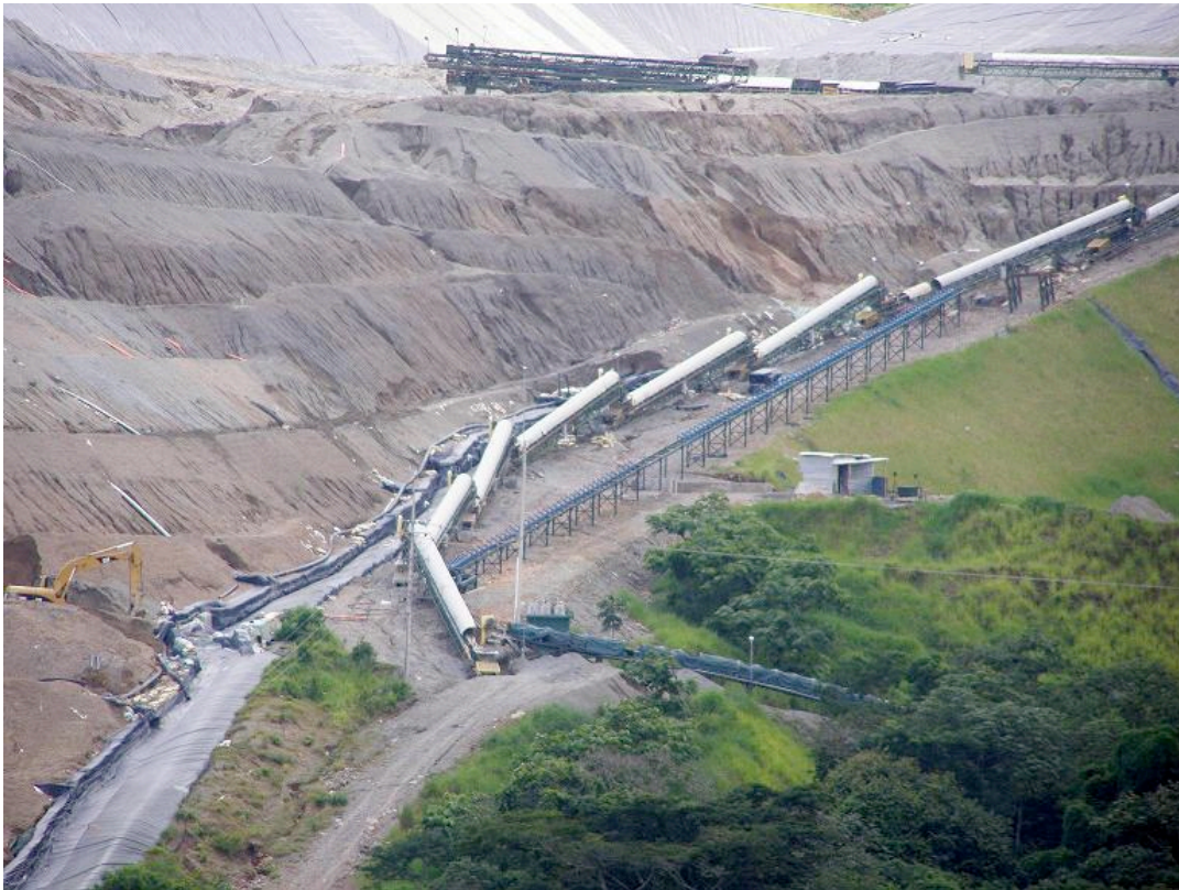
Daño minero en Bellavista, Costa Rica (fotografía: CEUS del Golfo)
